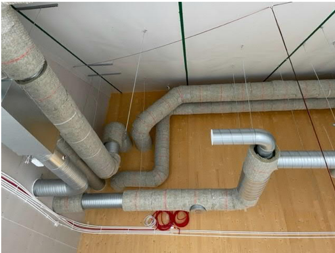
Pågående isolering av ventkanaler i Hus 2 plan 2.
