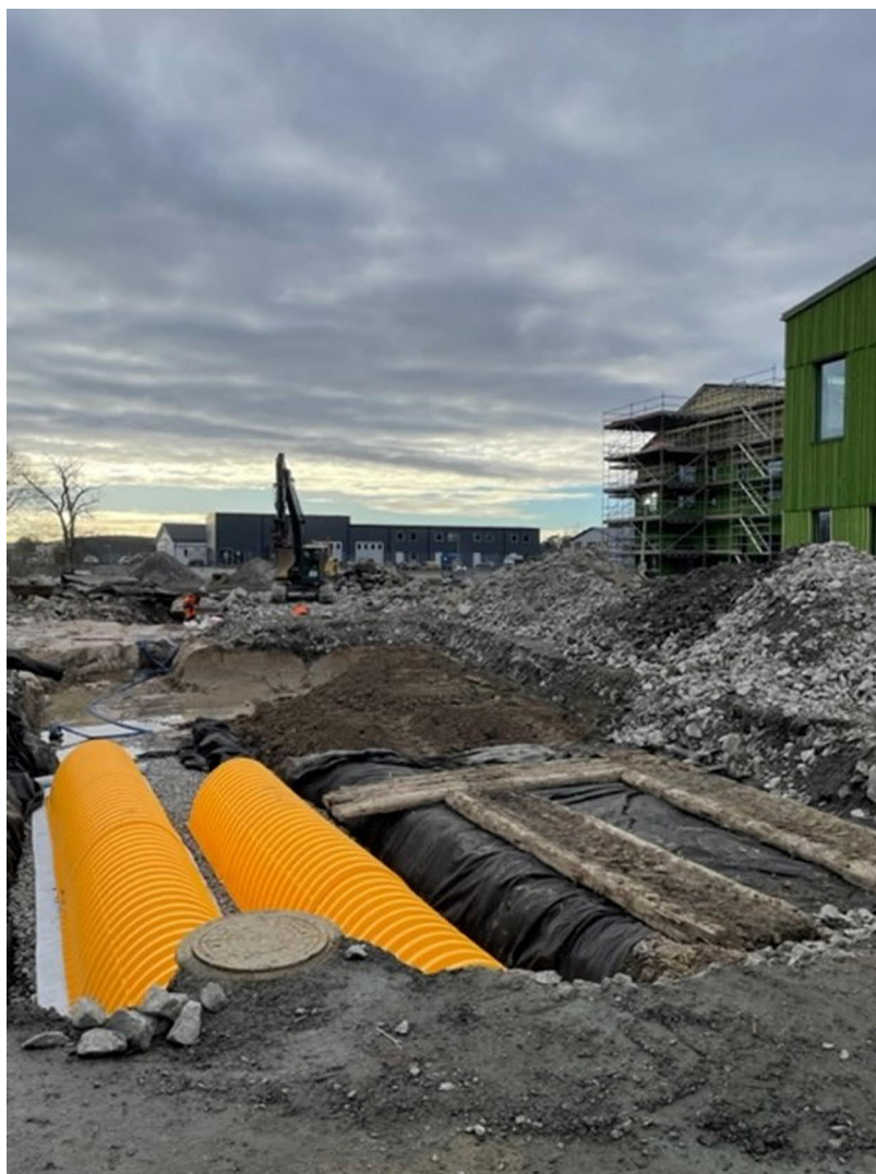
Läggning av fördröjningsmagasin och pågående sprängning.
