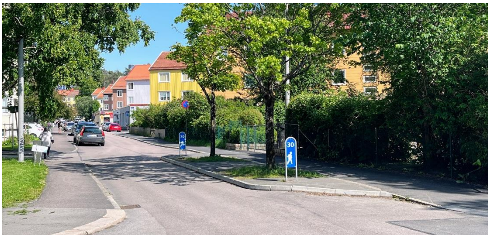
Figur 11. Avsmalning som integrerar träd och möjlighet till dagvattenhantering.
