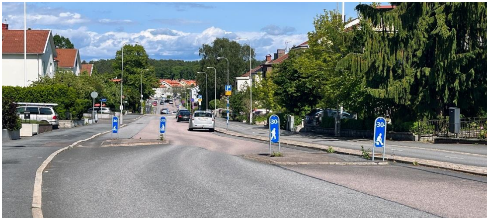
Figur 10. Avsmalning kombinerat med sidoförskjutning i form av chikan.
