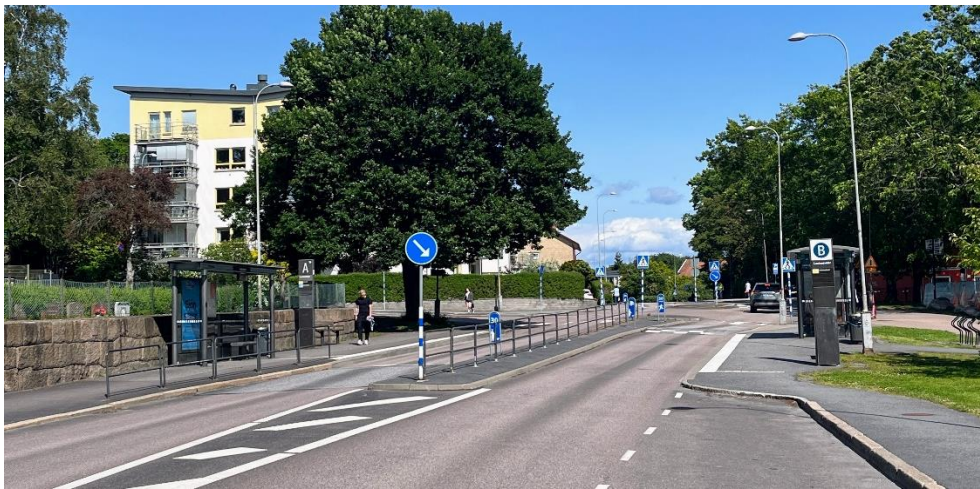
Figur 14. Exempel på enkel stopphållplats. Hastighetssäkrat övergångsställe finns i bortre änden i bild.
