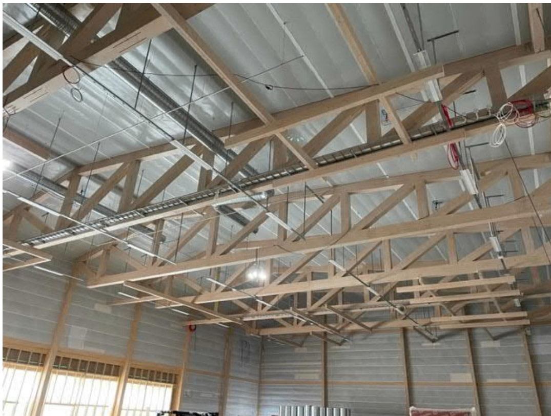
Del av taket i idrottshallen.
