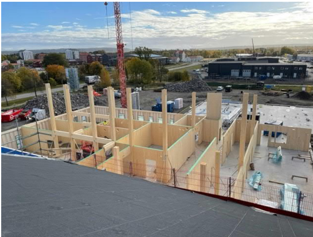
Pågående stommontage på Hus 3.
