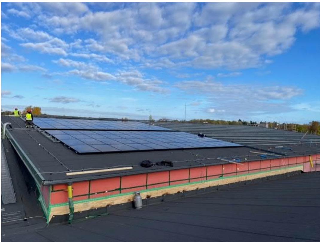
Pågående montage av solpaneler på idrottshallens tak.
