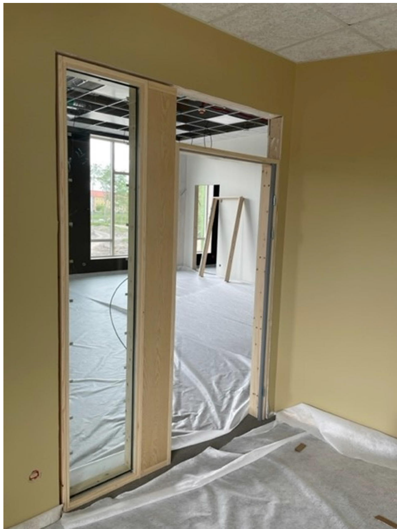
Pågående montage av dörrar och glaspartier i Hus 2.
