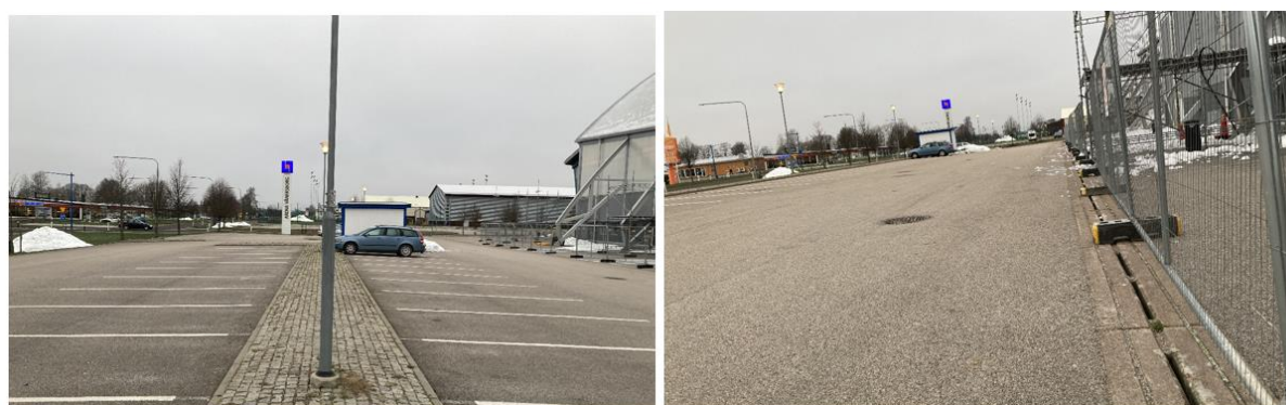
Parkering framför Arena Vänersborg mot söder. Refugen mitt på parkeringen delar av vattnet och mot arenans fasad finns en ränna där dagvattnet rinner ner till befintliga dagvattenkassetter.
