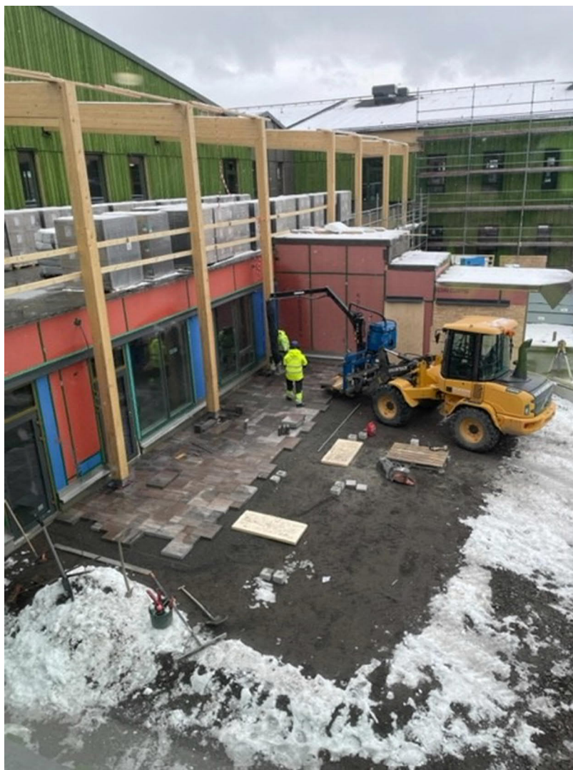
Utvändig plattläggning är påbörjad.
