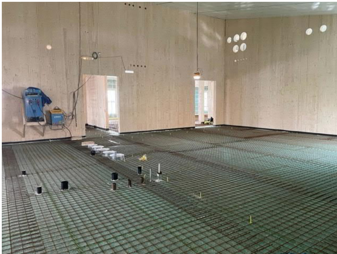
Hus 4 plan 2. Förberedande arbeten inför spackling av bjälklaget.
