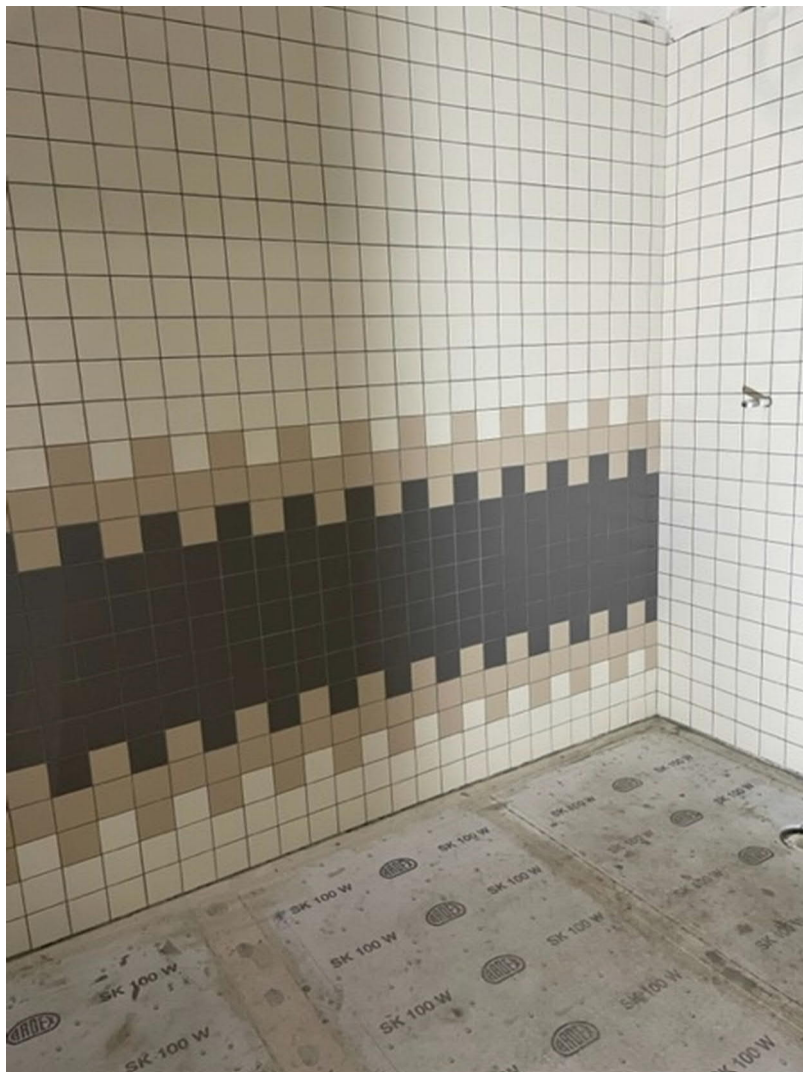
Hus 2 plan 2. Plattsättning i ett av duschrummen.
